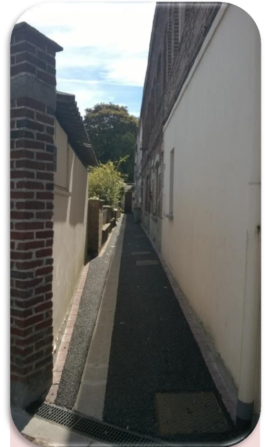
Enfouissement réseau Pavillon St Martin 63 250 Euros
