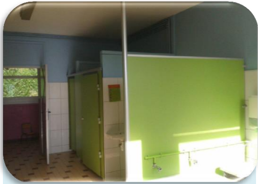
École Meliès , mise en conformité PMR 13 596 €
