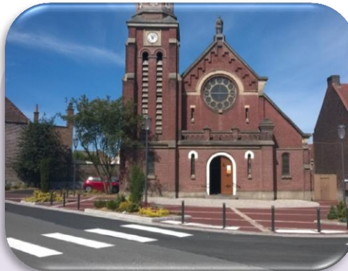
Enfouissement réseau - quartier Plouich 51 600 Euros
