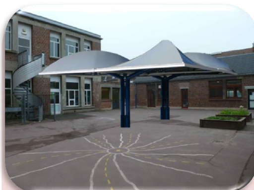
Aménagement de l'école Cognacq-Jay 286 020 Euros
